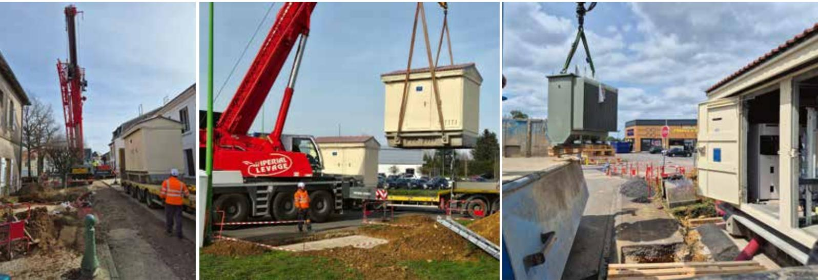
Insertion de postes Haute Tension : au centre du village en prévision des travaux futurs en lieu et place de l'ancien cinéma, dans la zone artisanale pour l'installation de bornes de recharge pour véhicules électriques (IRVE).
